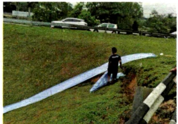
Tindakan sementara dilakukan dengan memasang kanvas dan menutup sebelah lorong.
